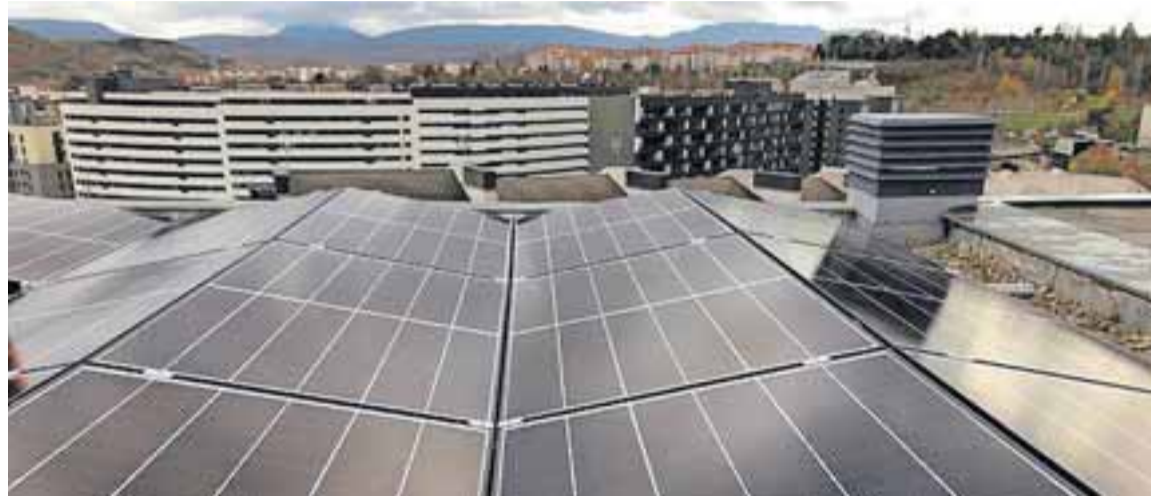
Instalación de placas solares desarrollada por Parques Solares de Navarra en la Comarca de Pamplona. CEDIDA
