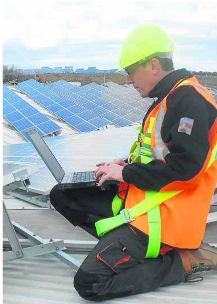
Empresa del polígono Ave María donde funciona el tejado. :: IDEAL
